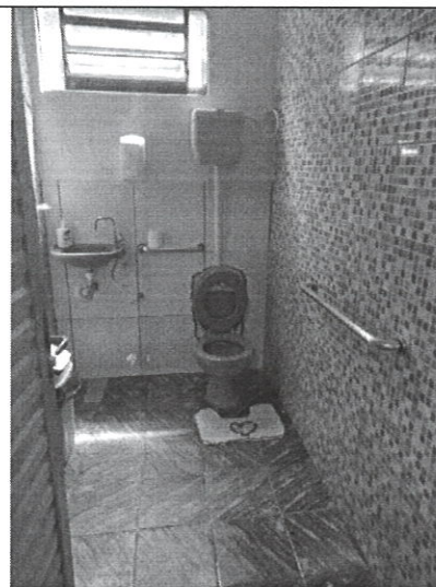
BANHEIRO- 1º pavimento
