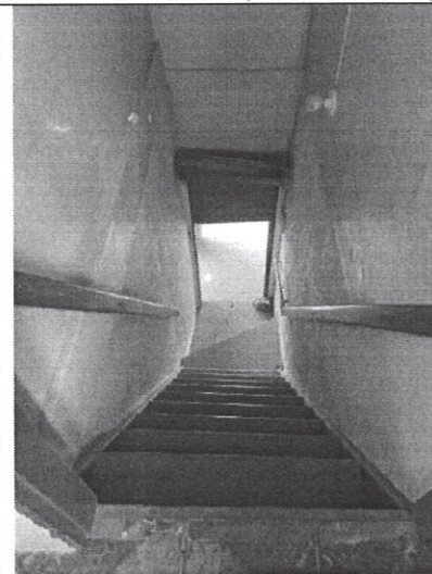
ACESSO A SEGUNDO PAVIMENTO
