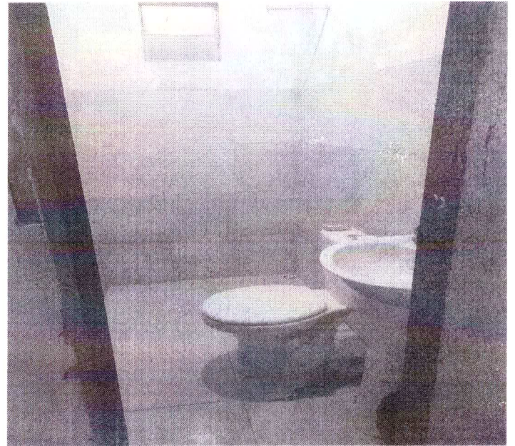
BANHEIRO DO PRÉDIO EXTERNO
