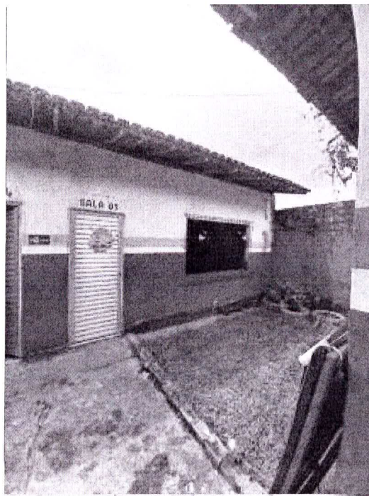
Figura 10 – Anexo de sala de aula.
